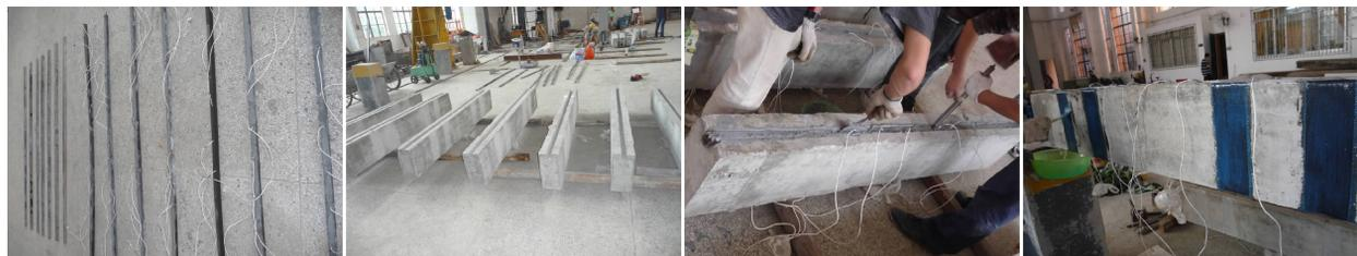
图 1 加固梁的制作过程
